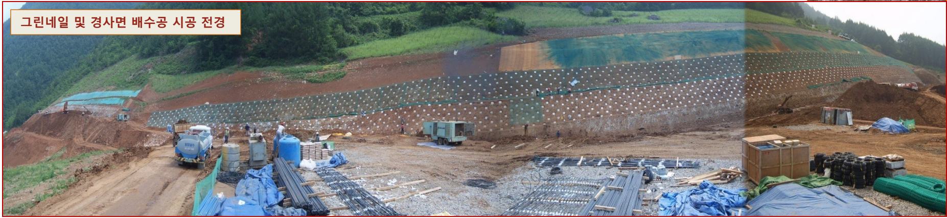
그린네일 및 경사면 배수공 시공 후 표면부 녹화공 시공전경
